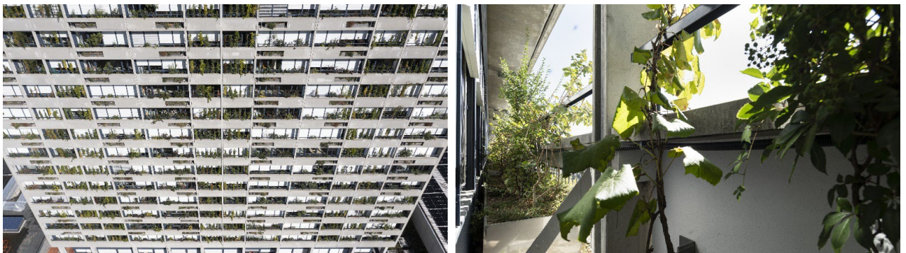
Abbildung 2: Fassadenbegrünung des Triemli-Spitals nach Fertigstellung. Das Bild links zeigt eine Aufnahme der Fassade mittels Drohne. Das Bild rechts zeigt eine Nahaufnahme der bepflanzen Pflanztröge. (Fotos: Gaëtan Bally)
